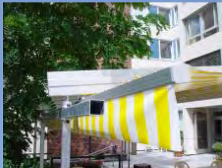
Laufschiene (verstärkt) auf Traverse montiert.
