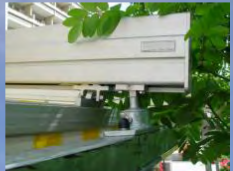
Laufschiene (verstärkt) auf Traverse montiert.
