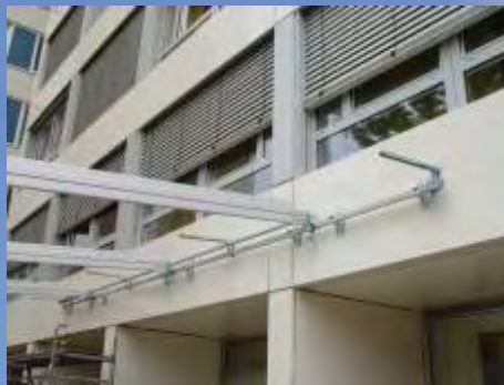
Tragerrohr und Laufschiene (verstärkt) montiert.
