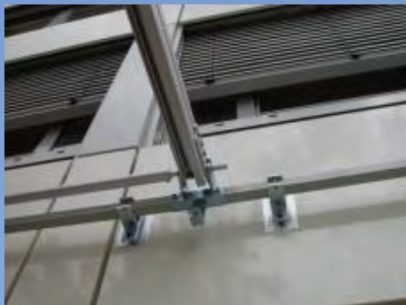
Tragerrohr in Montagekonsolen eingesetzt.
