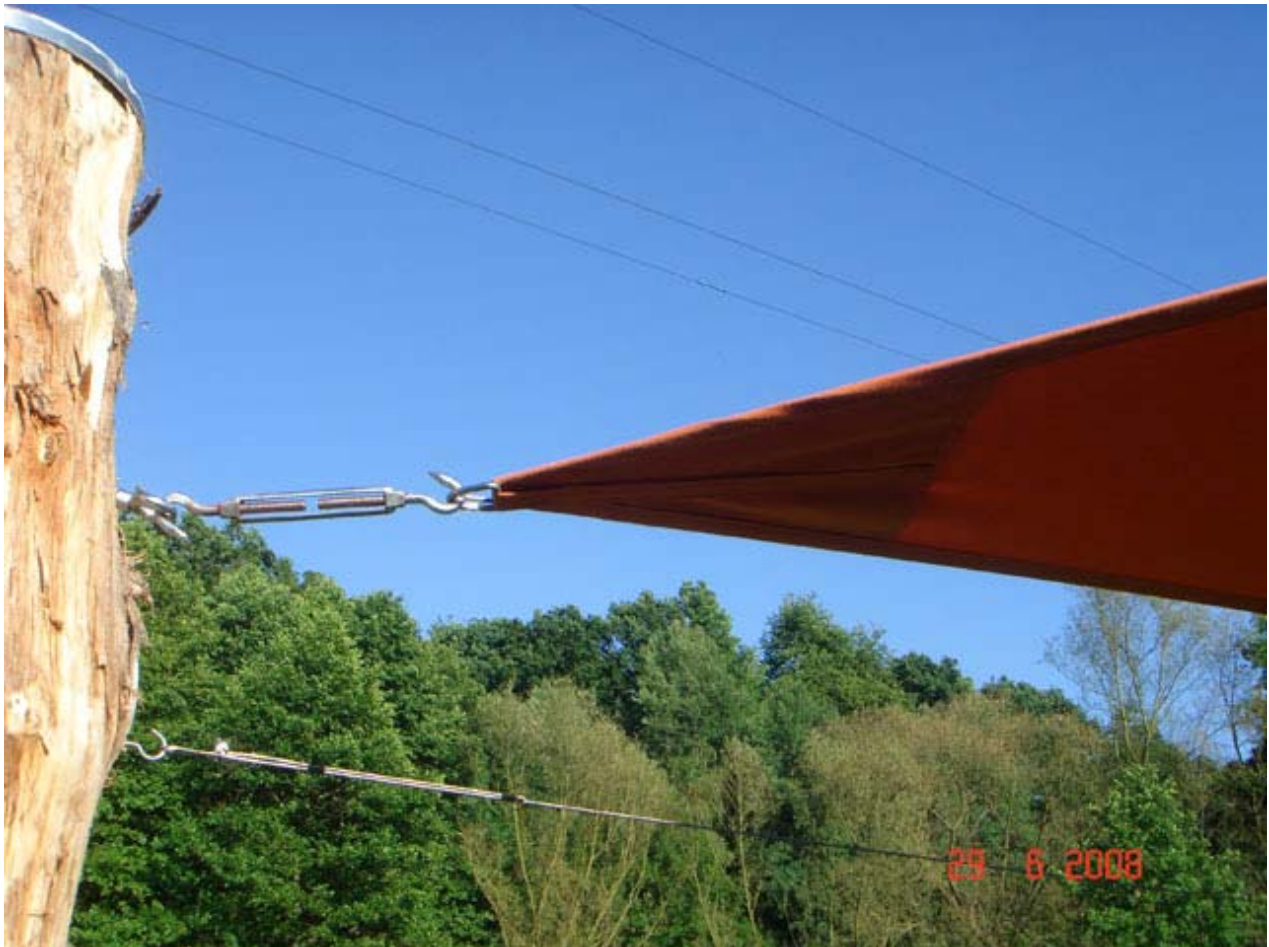
Detail: Verspannte Ecke mit Spannschloss (Seilspanner)
