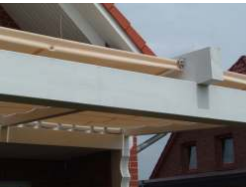
Montage zwischen die Sparren
